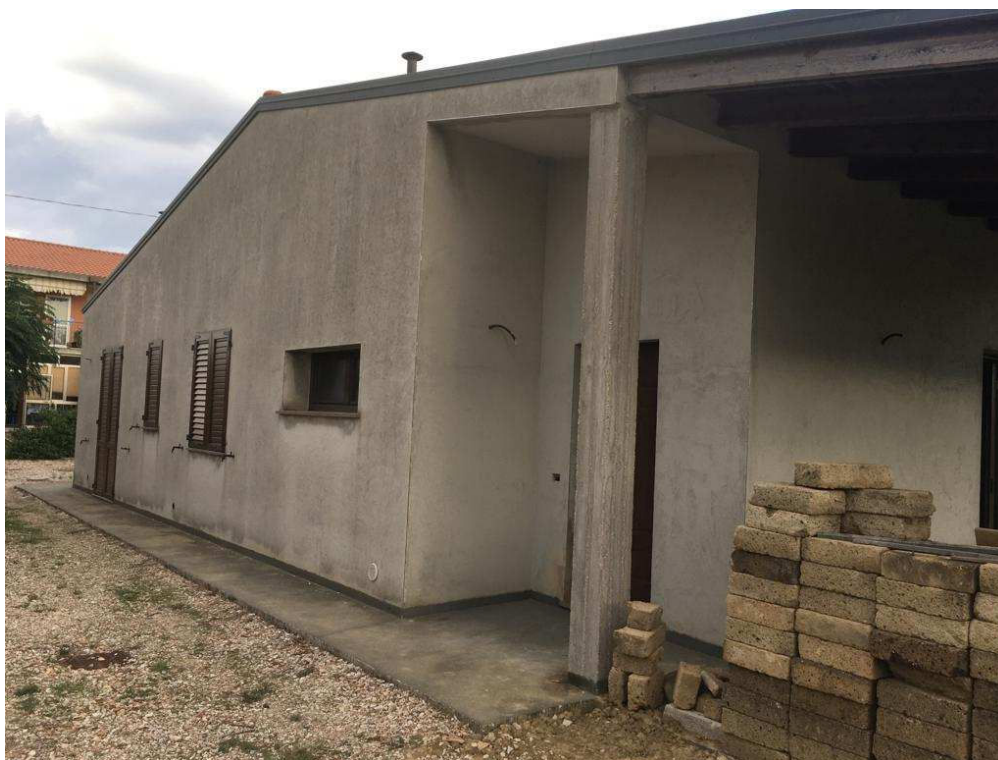
FOTO n. 3 – Vista lato Nord
